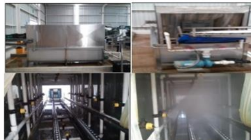
Figura 2. Lavado de contenedores de cajas de plástico. Sistema de aspersión de agua.
